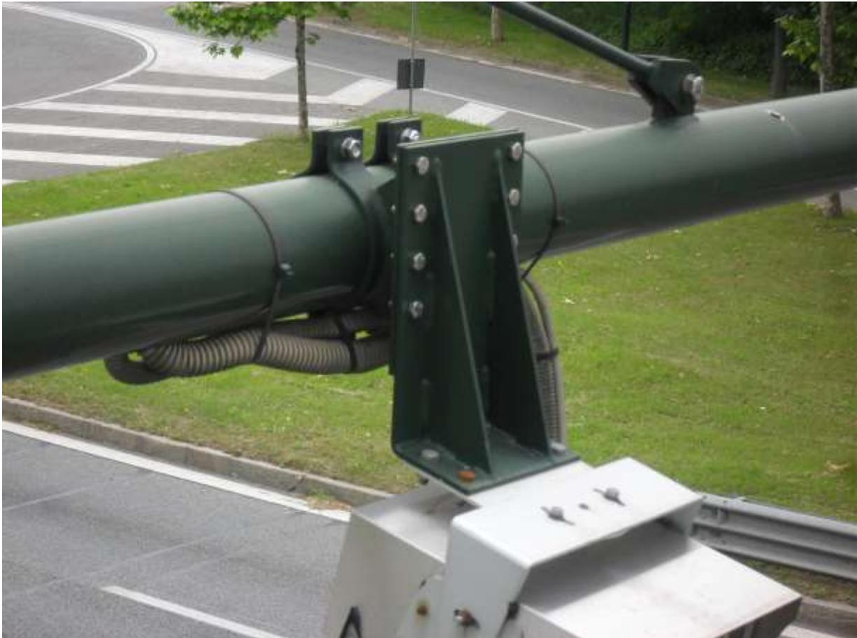
**Figura 1 - Staffa - solidale al braccio - di sostegno telecamera di sanzionamento impianto di controllo elettronico della velocità di corso Regina Margherita esistente.**
