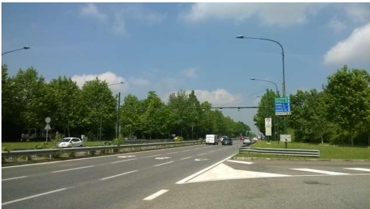
Figura 1 - Impianto esistente di controllo elettronico della velocità di corso Regina Margherita
