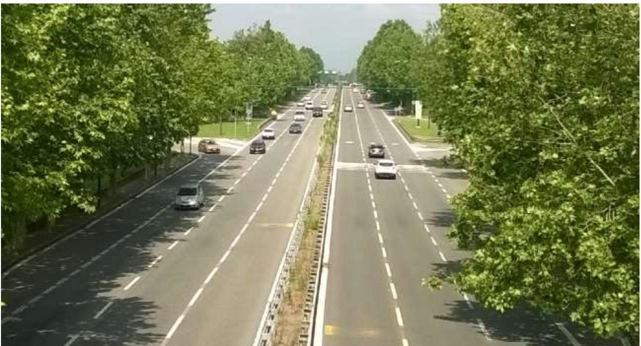
Figura 3 - Impianto esistente di controllo elettronico della velocità di Corso Regina Margherita visto dal Cavalcavia di Via Pietro Cossa in direzione della Tangenziale Nord di Torino.
