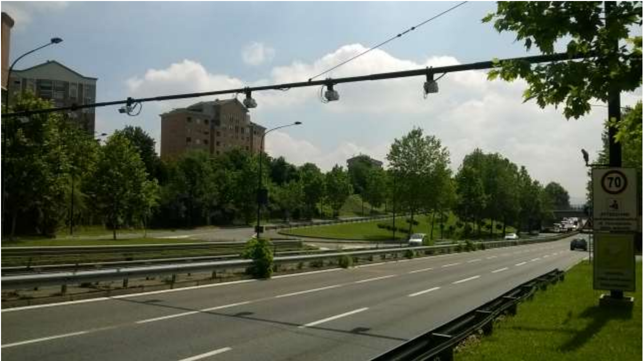
Figura 2 - Infrastruttura esistente con installate le telecamere di sanzionamento della velocità di Corso Regina Margherita.
