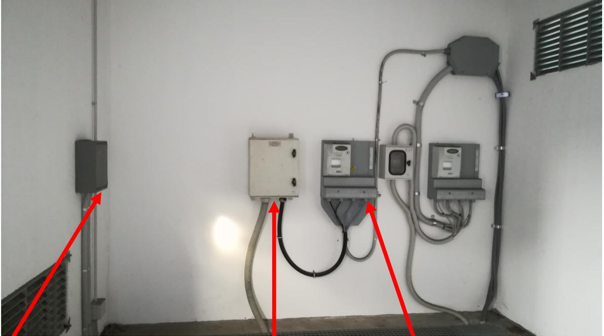
Figura 1: Punto di connessione ADSL, quadro generale, contatore elettrico di servizio al sottopasso di Piazza Statuto.
