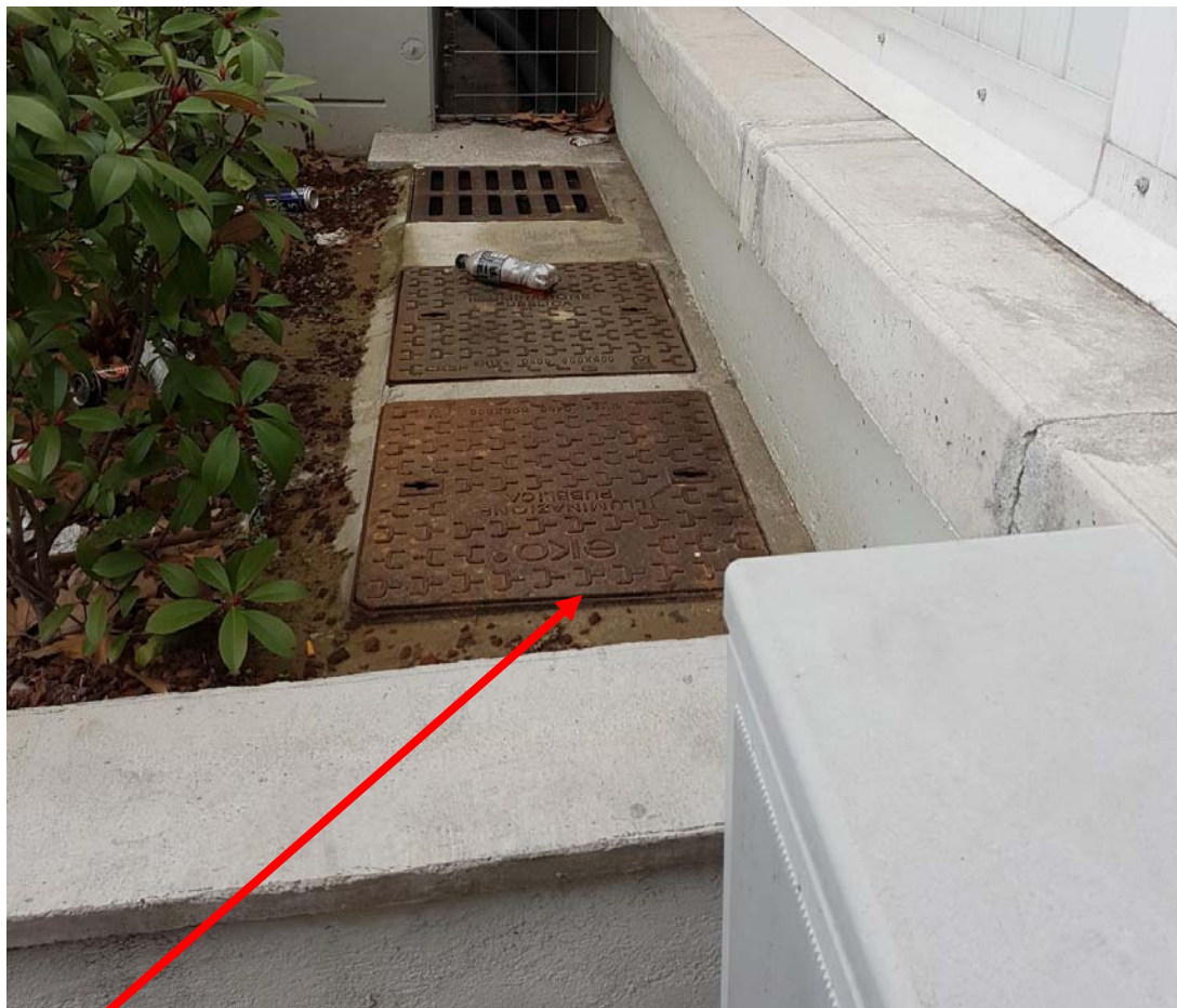
Figura 3: Pozzetto di collegamento nuove dorsali n. 1 e n. 2 e collegamento nuova tubazione locale pompe del sottopasso di Piazza Statuto con locale cabina elettrica
