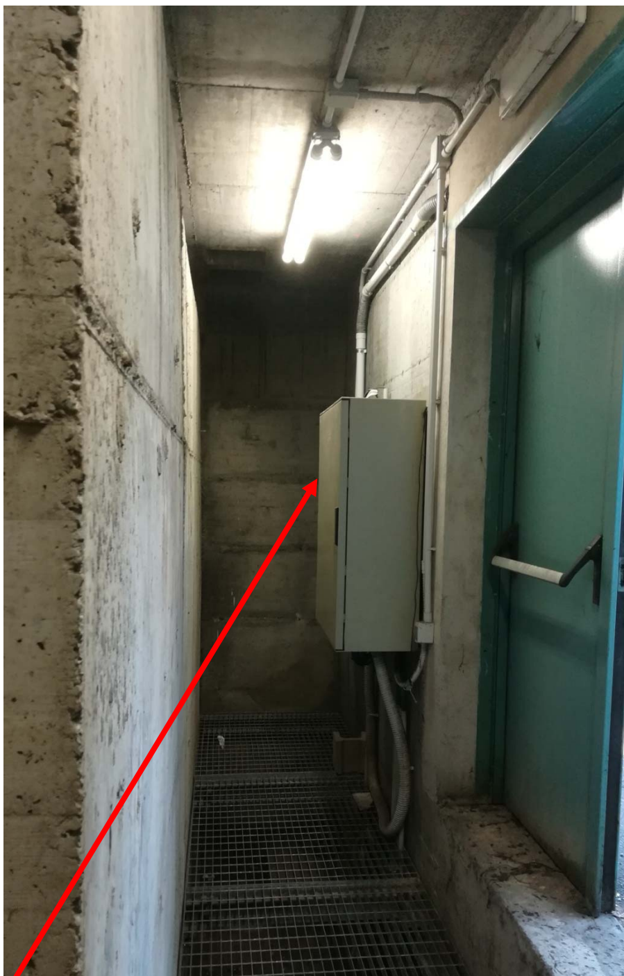
Figura 13: Armadio di controllo del locale pompe del sottopasso di Piazza Statuto che dovrà essere collegato tramite delle nuove tubazioni con le nuove canalizzazioni previste.
