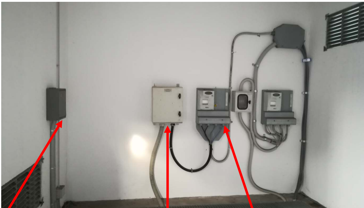
Figura 1: Punto di connessione ADSL, quadro generale, contatore elettrico di servizio al sottopasso di Piazza Statuto.
