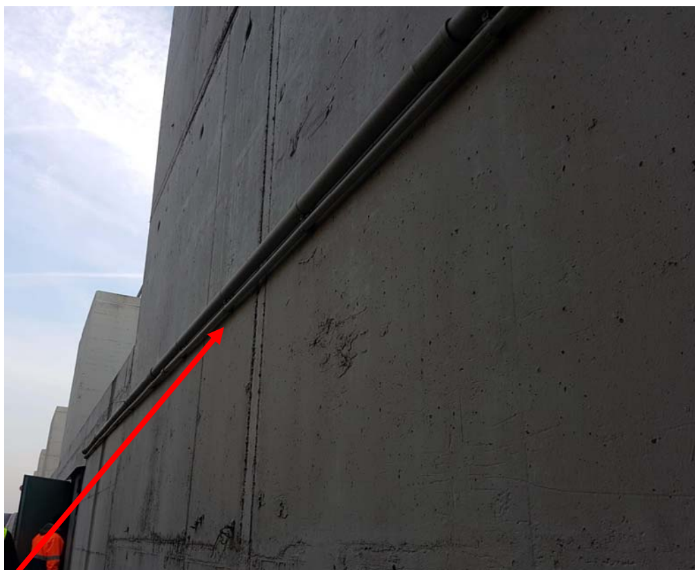
Figura 15: Posa di una nuova tubazione di acciaio per raccordo quadro di controllo pompe con nuova rete canalizzazioni.
