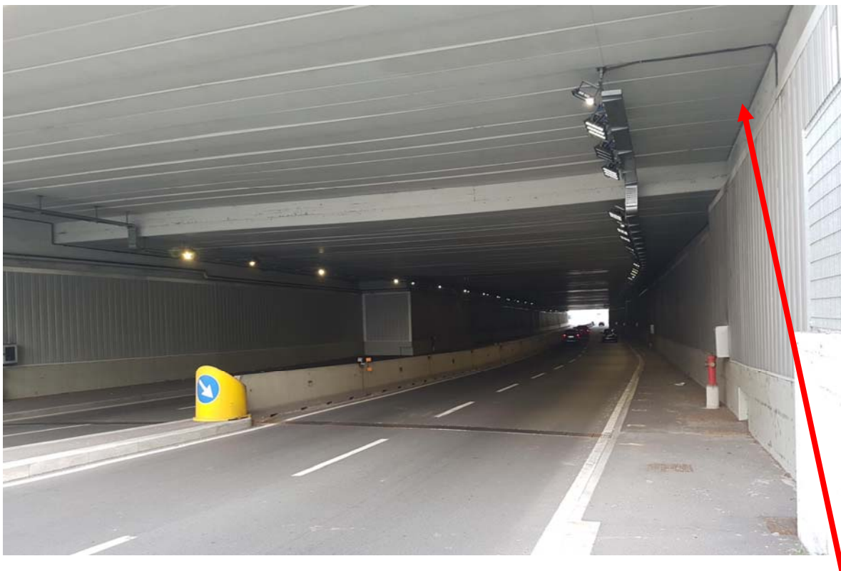
Figura 4: Installazione canaline nuova dorsale n. 1 entrata sottopasso direzione Corso Principe Oddone
