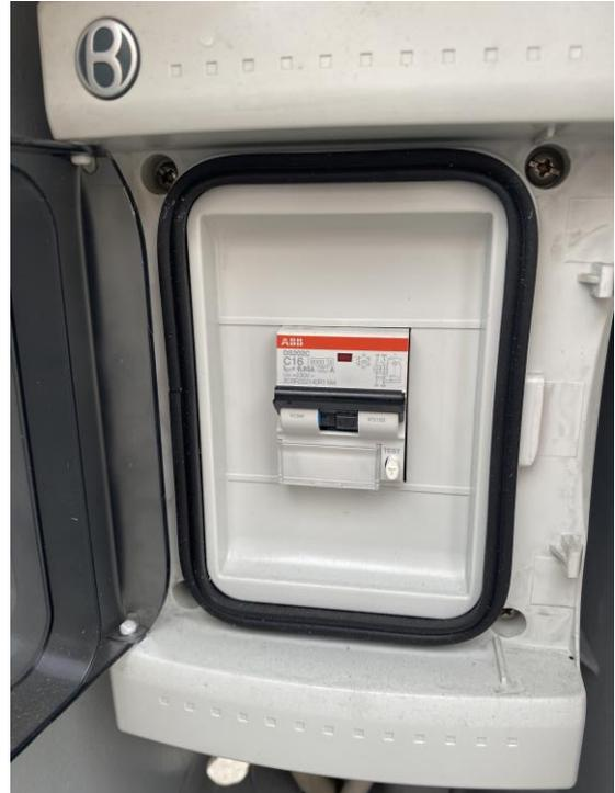
**Figura 6: Dettaglio colonnina porta-interruttore da fornire, collegare ed installare**
