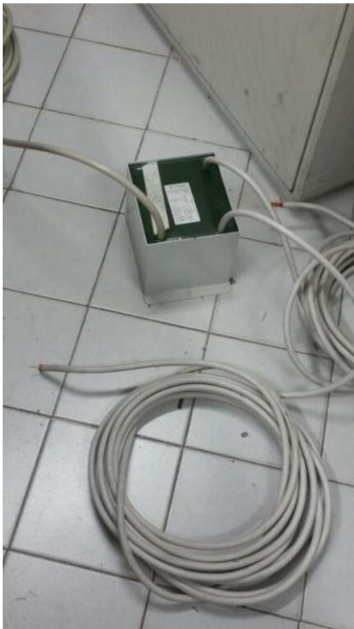
**Figura 4: Trasformatore monofase di sicurezza 230VAC - 24VAC
