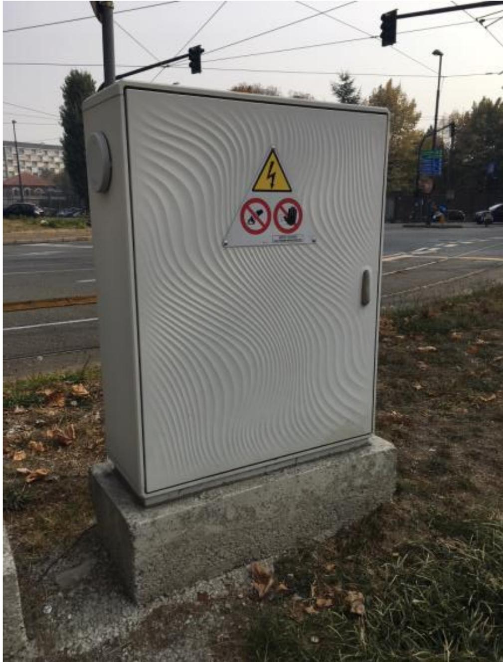
**Figura 2: Armadio stradale cablato 5T da fornire, collegare e installare su basamento esistente**
