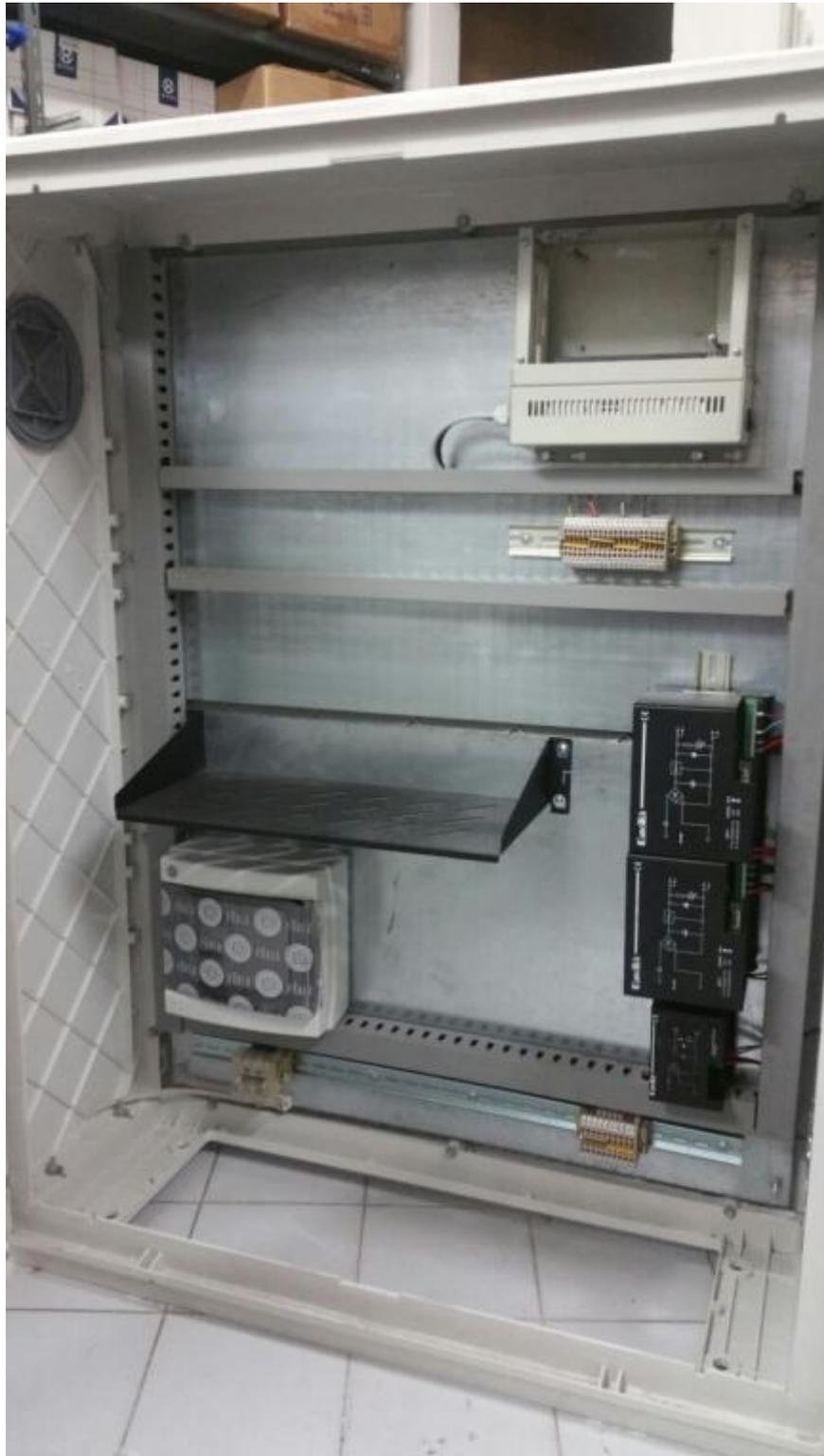
Figura 3: Armadio stradale cablato con predisposizione per apparati 5T
